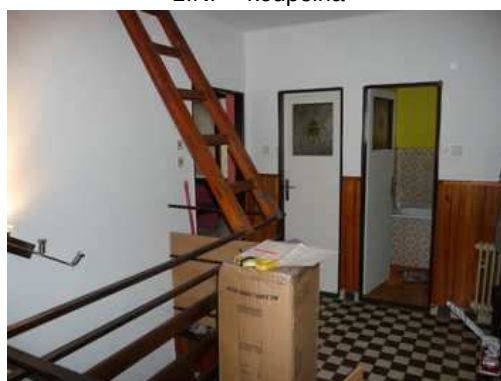
2.NP - chodba se schodištěm
